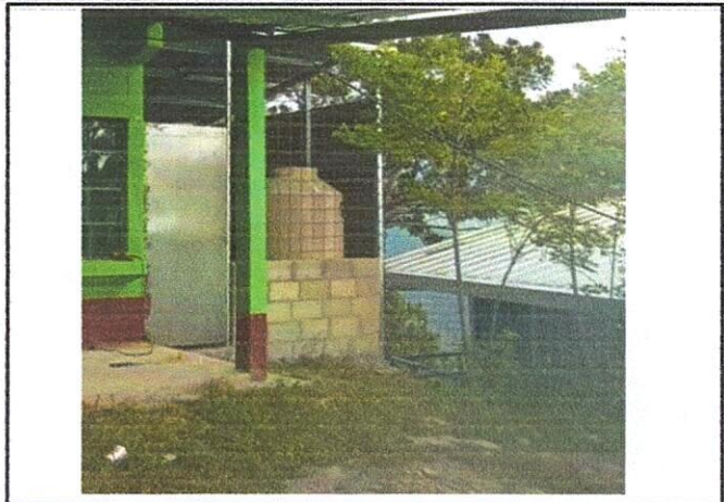
Foto 2: Mejoramiento de cocina
